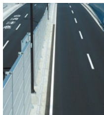
「ユニビーズ」使用道路 (センターライン)
