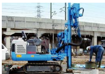
簡易ボーリングマシンによる試料採取作業
