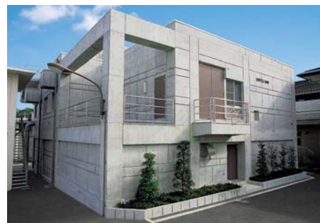
北郡山浄水場
