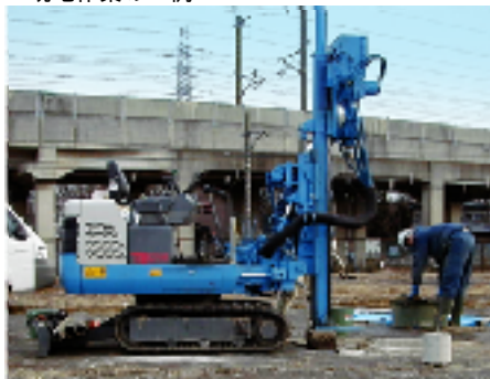
▲簡易ボーリングマシンによる試料採取作業
