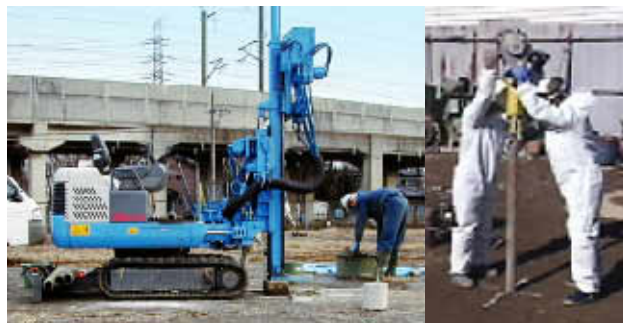
簡易ボーリングマシンによる試料採取作業
