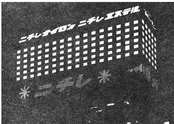
東京事務所屋上の新ネオン塔
