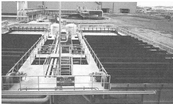
UF式廃水処理装置
