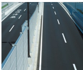
「ユニビーズ」使用道路 (センターライン)
