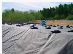
福島県内、除染廃棄物仮置き場での施工状況
