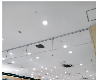
透明性に優れたガラス繊維強化樹脂シート「ユークリアーシート」 使用例：防煙垂壁
