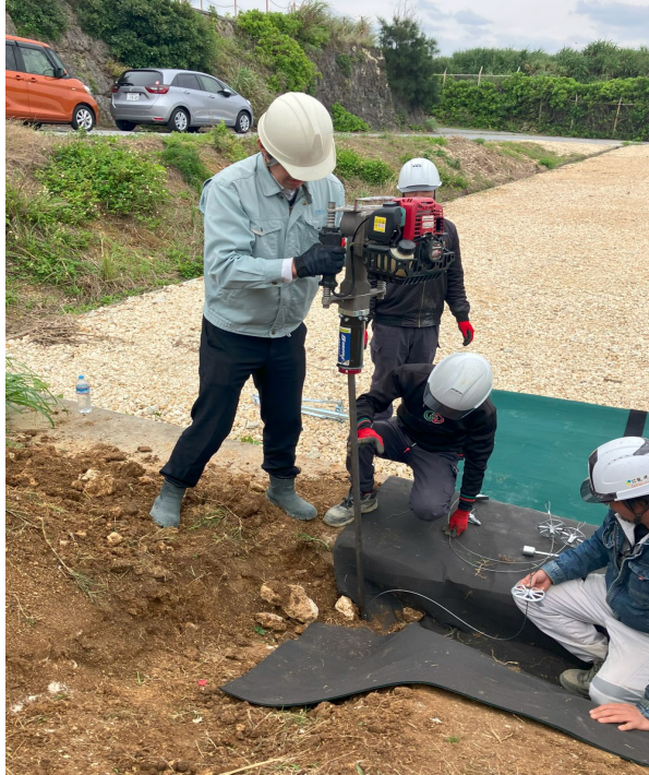
(写真1) 耐風性向上の為の特殊アンカーによる設置状況
