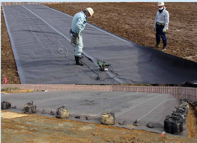
現場で溶着作業が可能です
