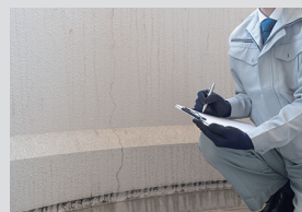
構造物の保護・補強
