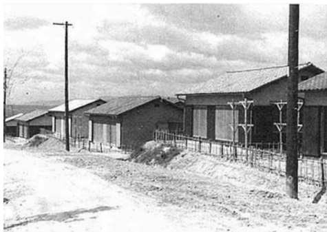
建設中の城陽団地
