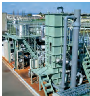
繊維ろ過による合流式 下水道改善処理システム
