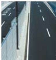
「ユニビーズ」使用道路 (センターライン)
