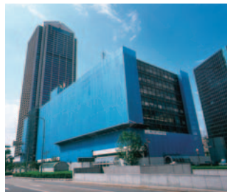
建築工事前防炎メッシュシート
