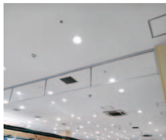
透明性に優れたガラス繊維強化樹脂シート 「ユークリアーシート」 使用例：防煙垂壁
