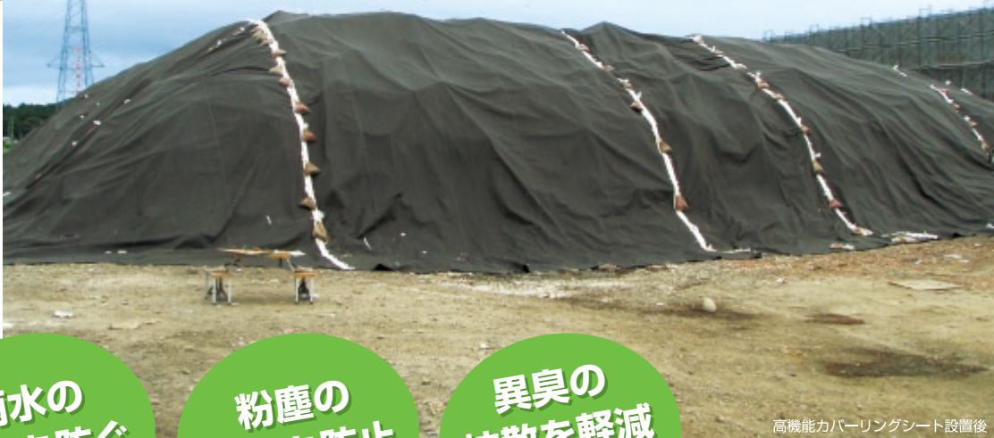
高機能カバーリングシート設置後
