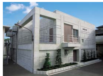
北郡山浄水場
