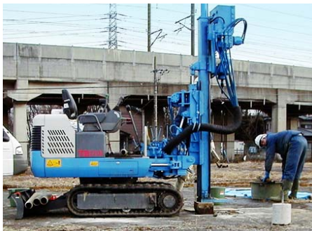
簡易ボーリングマシンによる試料採取作業
